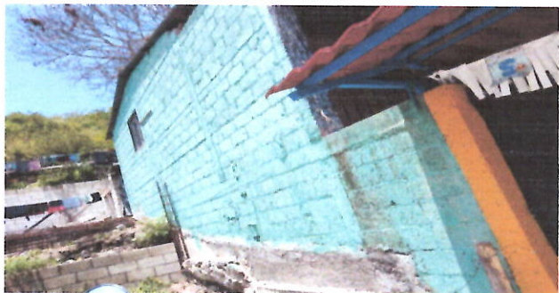
FOTO1: PINTURA EN MUROS INTERIOR Y EXTERIOR
