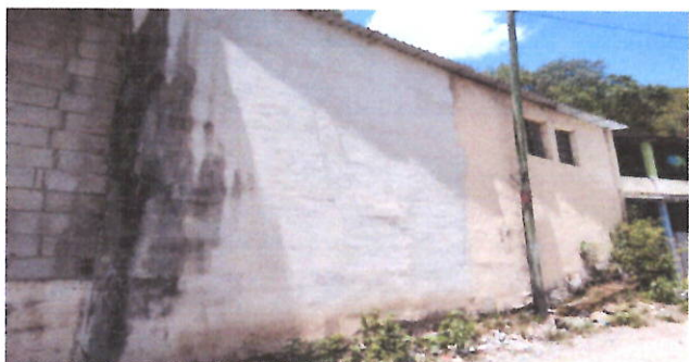
FOTO5: PINTURA EN MUROS INTERIOR Y EXTERIOR
